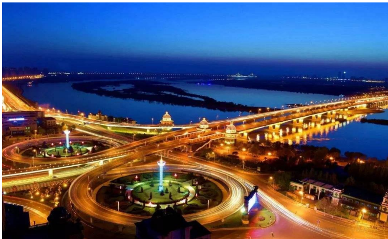
Мост развязки через Сунгари
